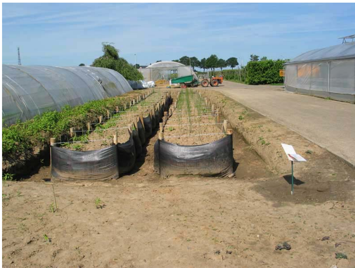
Figure 2 : Mise en place du nouveau système
